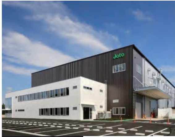
城東テクノ茨城工場写真
