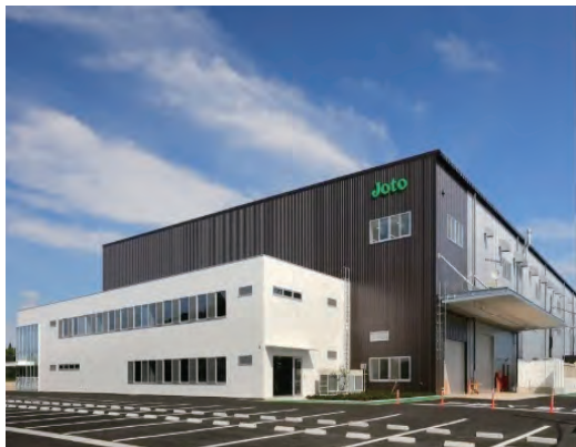
城東テクノ茨城工場写真
